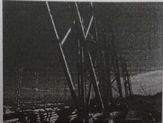
Coluna e estruturas de contraventamento
