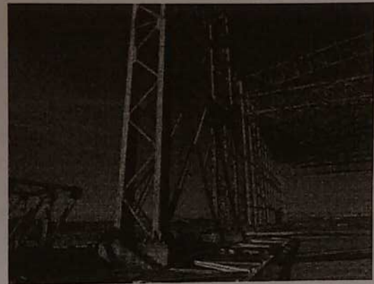
Lateral do galpão sem a cobertura e fechamentos executados
