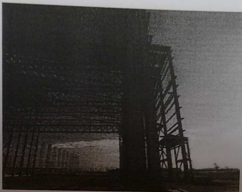
Lateral sem o fechamento executado.
