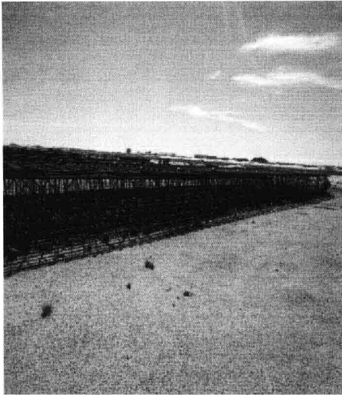
Armaduras Montadas (Lamelas)
