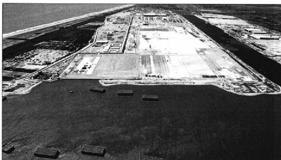
Figura 2.1.b – Visão aérea da área do Complexo Industrial do Porto do Açu
